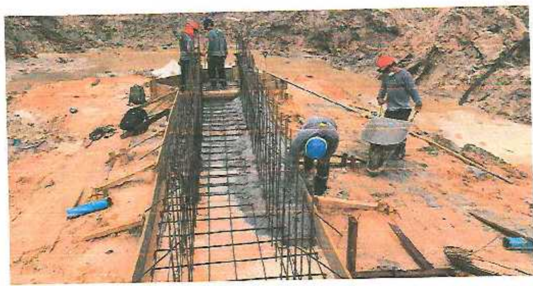
SE APRECIA LA COLOCACION DE ACRO EN PROGRESIVA 1+564 Foto N° 13
