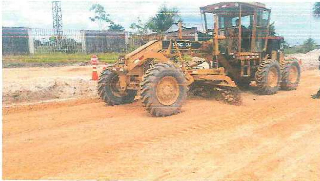
SE APRECIA PERFILADO EN LA CARRETERA
