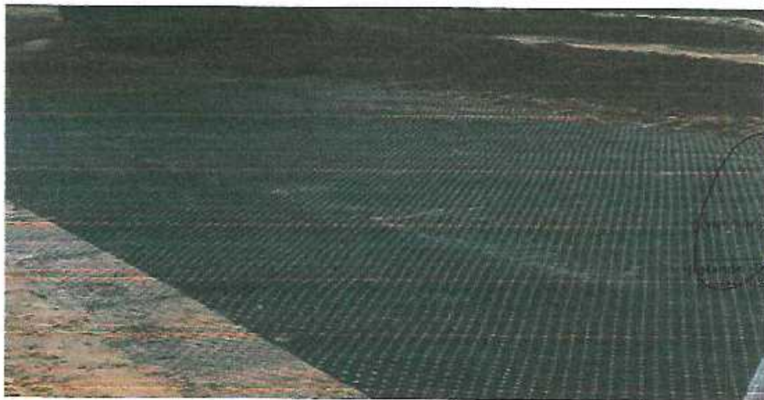
APRECIAMOS TENDIDO DE GEOMALLA Foto N° 09
