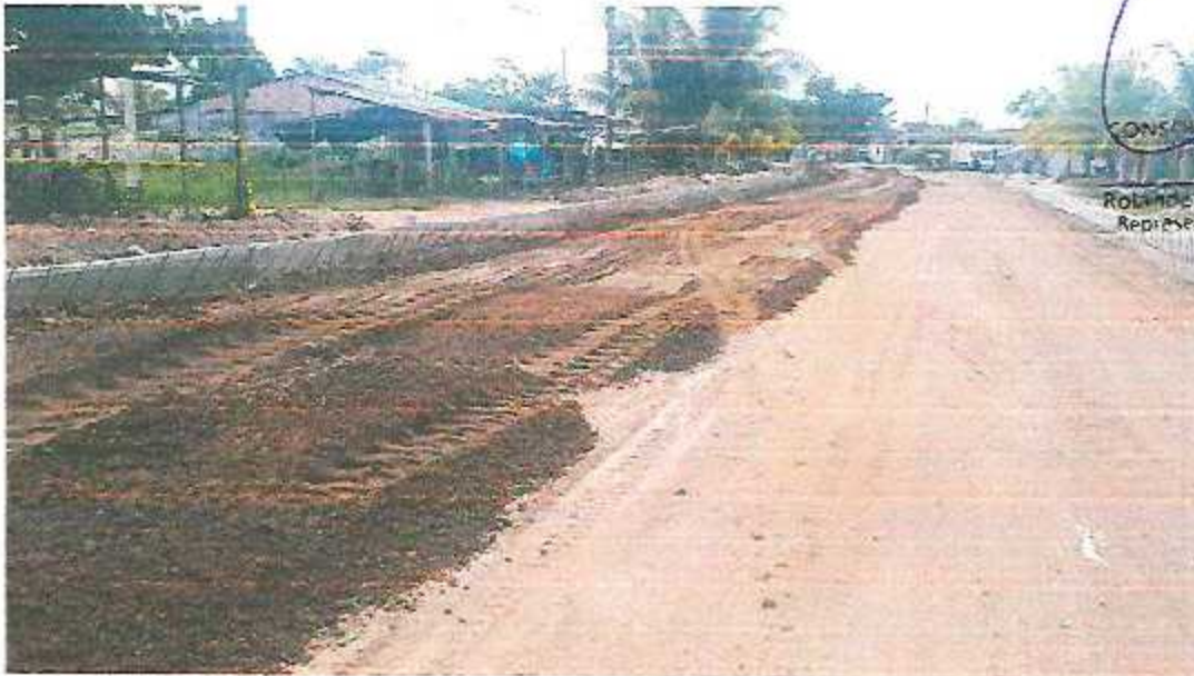
COLOCAION DE SUB BASE CONSORCIO VIAL ARGRIP Foto N° 06
