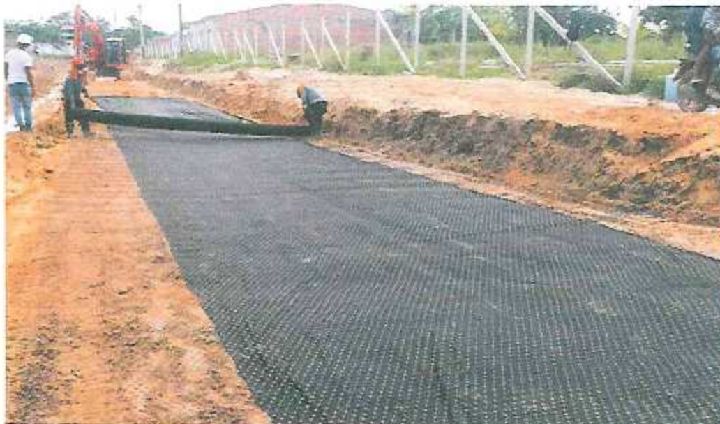
CONSORCIO VIAL ARGRIP APRECIAMOS TENDIDO DE GEOMALLA Foto N° 10 Ing° RAÚL PINEDA RODRIGUEZ RESIDENTE DE OBRA CIP N° 31118
