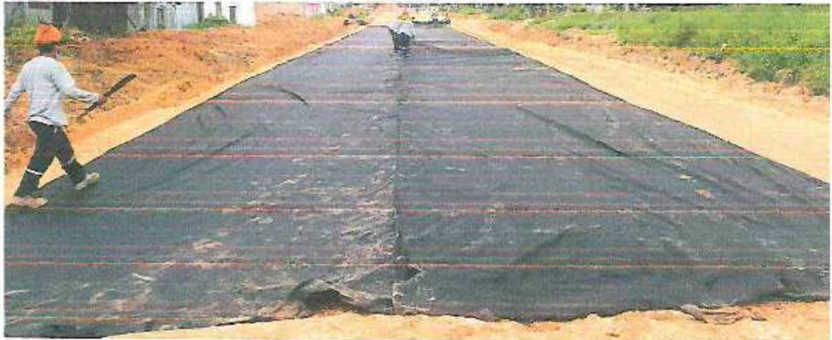
APRECIAMOS TENDIDO DE GEOMALLA Foto N° 09
