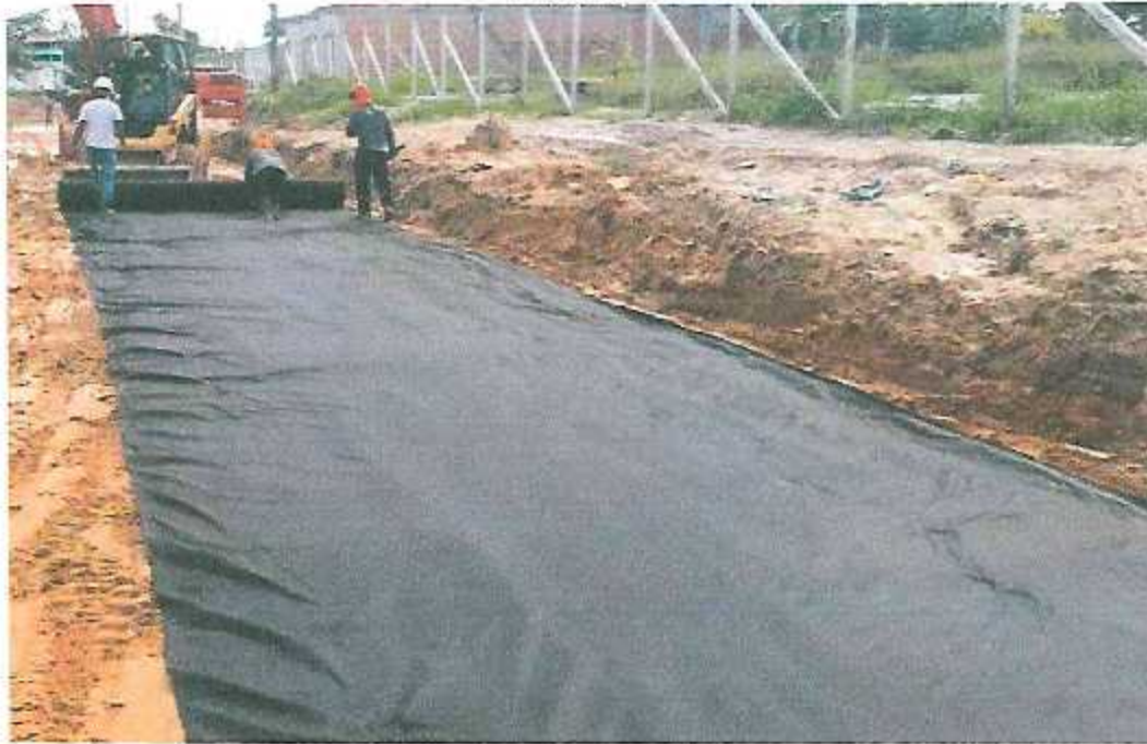
APRECIAMOS TENDIDO DE GEOTEXTIL Foto N° 09
