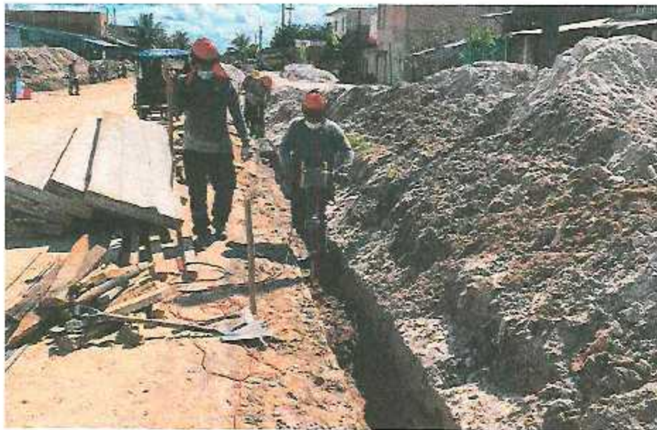
SE APRECIA LA EXCAVACION DE SARDINELES Foto N° 16
