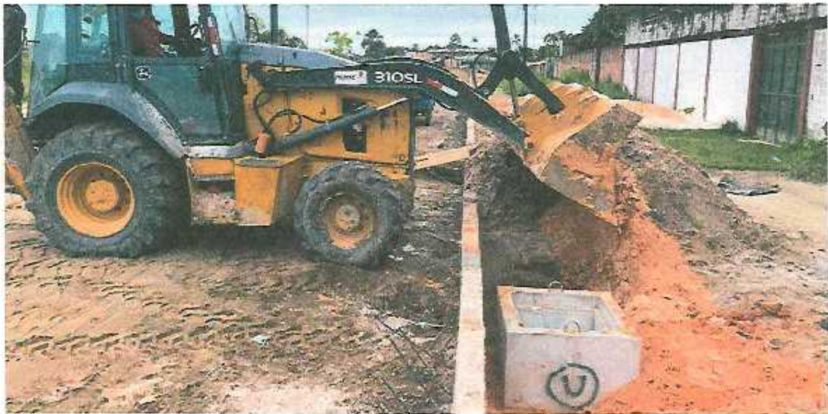
SE APRECIA LA COLOCACION DE CAJA DE INSPECCION DE SUBDREN
